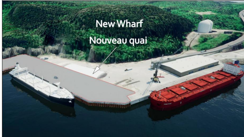
Deuxième quai prévu au port de Saguenay, Québec, Canada
