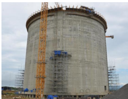
Construction of the LNG Tank
