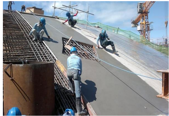
Construction of LNG Tank Roof
